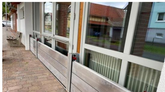
**Abbildung 28: Hochwasserschutztor Triftberghalle Mosbach (Quelle: TMUEN)**
